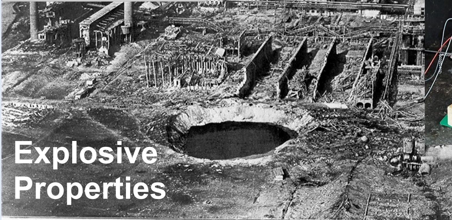
VUE AÉRIENNE DE L'USINE DE LA « BADISCHE ANILIN UND SODA FABRIK », A OPPAU, APRÈS LA FORMIDABLE EXPLOSION DU 21 SEPTEMBRE 1921. Au premier plan, le cratère formé par la mystérieuse déflagration et à demi rempli d'eau par les canalisations rompues et par les infiltrations souterraines; au delà, les bâtiments rasés ou déformés. Photographie prise d'un avion spécialement envoyé sur les lieux, pour l'illustration, par la Compagnie Aérienne Française. — Tous droits réservés.
